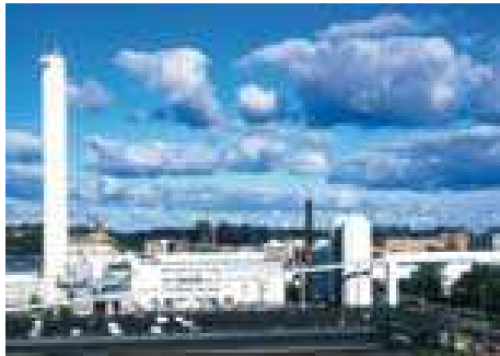
Biogas da trattamento acque usate e rete di teleriscaldamento
