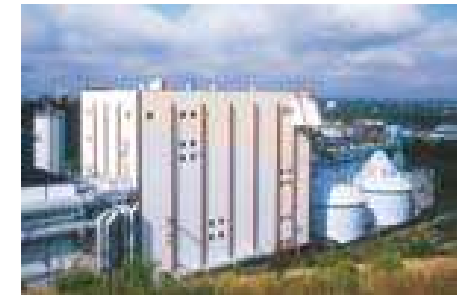
Termovalorizzatore e rete di teleriscaldamento
