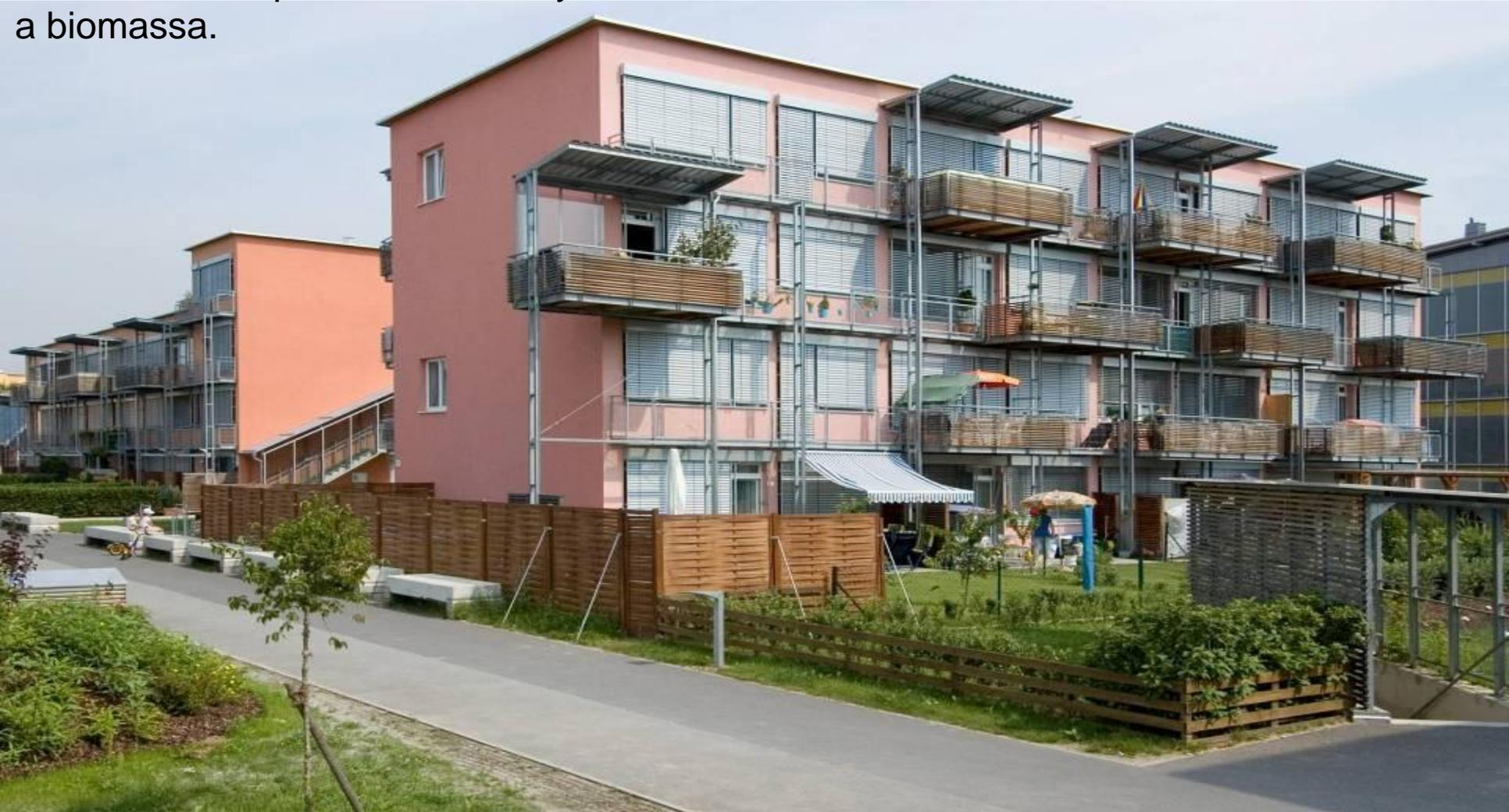
Il fabbisogno energetico medio degli edifici è di circa 21-28 kWh/mq anno, contenuto grazie all'impiego di sistemi passivi, quali serre solari e brise-soleil, e sistemi attivi quali pannelli solari e ventilazione meccanica con recupero di calore.
